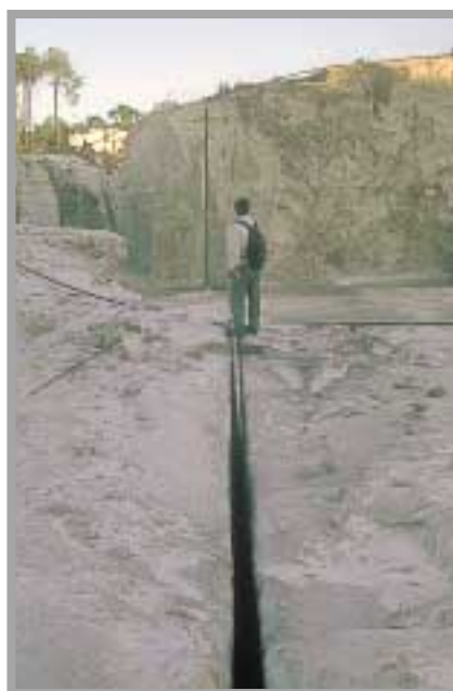
Corte inicial realizado con lanza térmica. Foto: A. Bueno, 2003.
