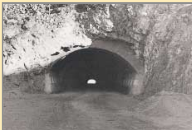
Socavón 16, el de mayor recorrido, que atraviesa el Cerro del Cinto y se utilizaba para el vertido de estériles al este. Foto: J. Barber, 1956. Archivo de Proyectos de la Escuela de Minas de Madrid.
