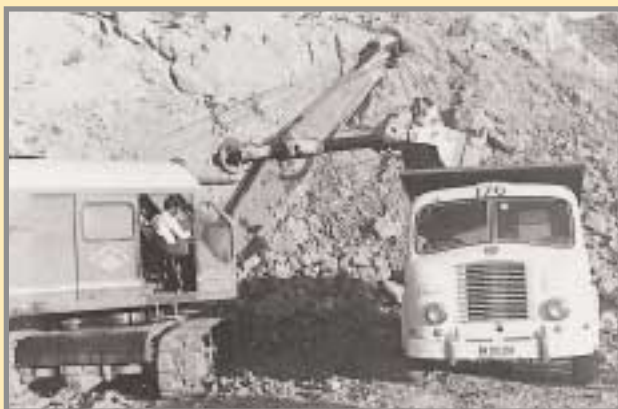
Trabajos de carga en el Dique 2 del Cerro del Cinto, en 1956. La posición de la pala y el camión es tal que la carga se realiza con el menor ángulo posible. Foto: J. Barber. Archivo de Proyectos de la Escuela de Minas de Madrid.
