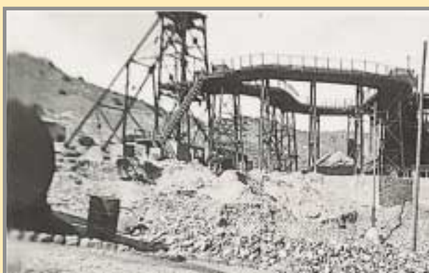
Castillete y taller de molienda por bocartes, en 1936. Mina "Consulta", de la Sociedad "Minas de Rodalquilar, S.A.". Foto: D. Morales. Archivo de Proyectos de la Escuela de Minas de Madrid.
