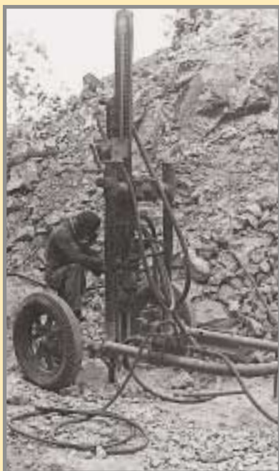
Máquina de sondeos o Wagon-Drill trabajando en la zona del Cinto, en 1956. Foto: J. Barber. Archivo de Proyectos de la Escuela de Minas de Madrid.
