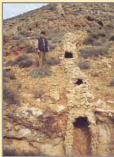
Tiro de la máquina de vapor de los Pozos de Teresa. Se trata de unas minas de caolín del s. XIX para la fábrica de cerámica de La Cartuja. Foto: F. Hernández, 12/2001.
