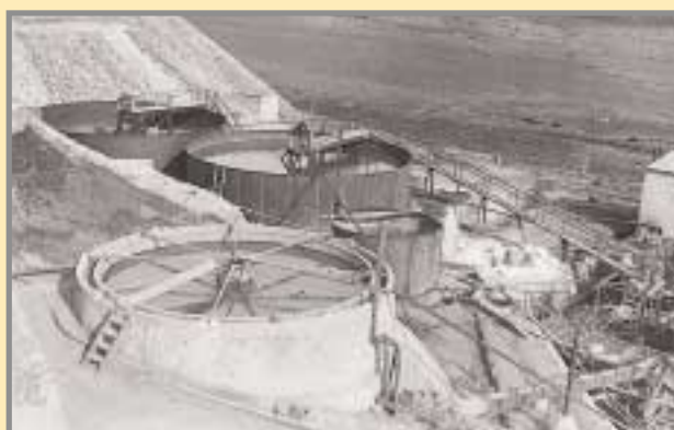
Tanques sedimentadores de la Planta Dorr, en 1936. Sociedad "Minas de Rodalquilar". Foto: D. Morales. Archivo de Proyectos de la Escuela de Minas de Madrid.
