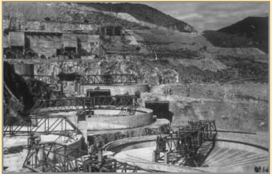
Desarrollo de la minería del oro en sus diferentes etapas: Tanques reactores en el lavadero de lixiviación de la etapa Adaro
