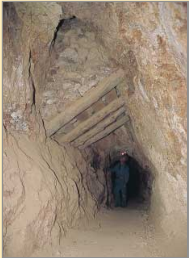
Bellos posteados sobre el hueco de filón en la mina "Las Niñas". La madera está perfectamente conservada en virtud de la sequedad del ambiente. Foto: G. García, 12/2003.
