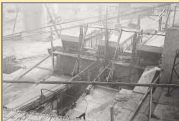
Baterías de mesas de concentración "Wilfley", en funcionamiento en la Planta Dorr (año 1936). Foto: D. Morales. Archivo de Proyectos de la Escuela de Minas de Madrid.
