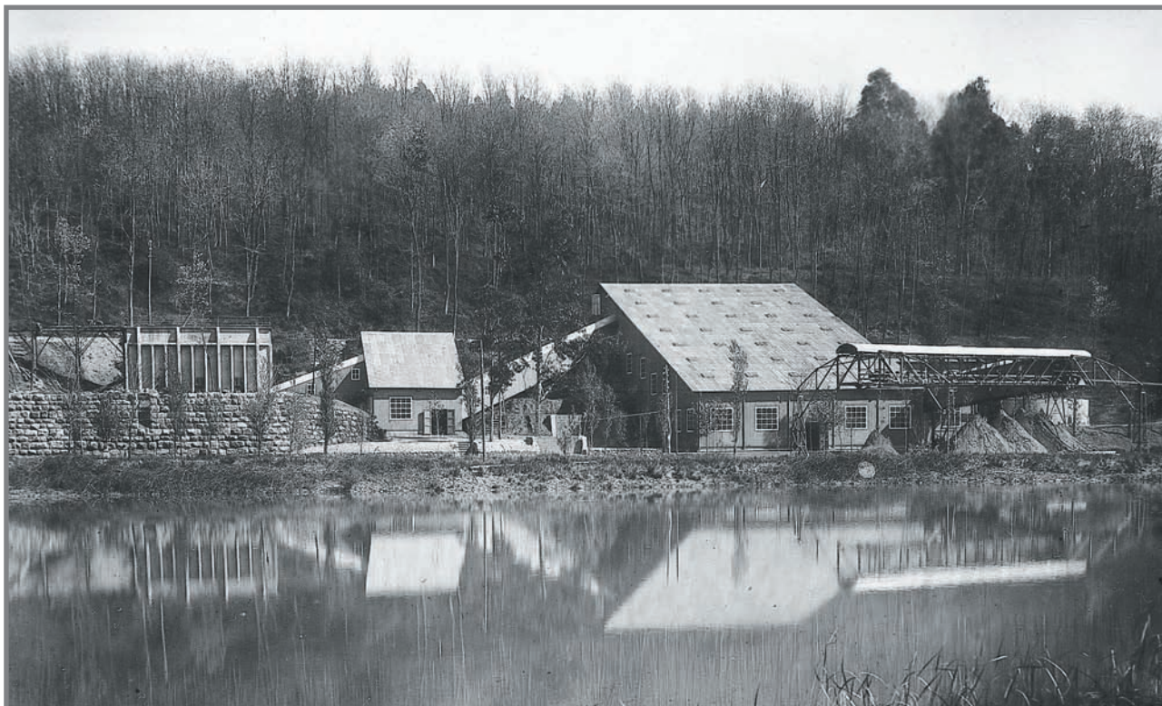
Taller de tratamiento de la Real Compañía Asturiana de Minas. De izquierda a derecha se aprecian las tolvas, las cintas, talleres de flotación y el parque de concentrados. Foto: C. Odriozola, 1930.
