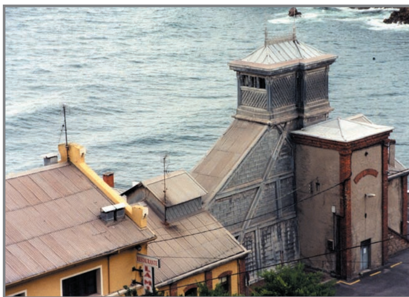
Aspecto actual del castillete de Arnao. Construido en 1845 y cerrado en 1912. Daba servicio a un pozo de 80 m. En 1858 descendió la Reina Isabel II. Foto: J. M. Sanchis, 8/2004.
