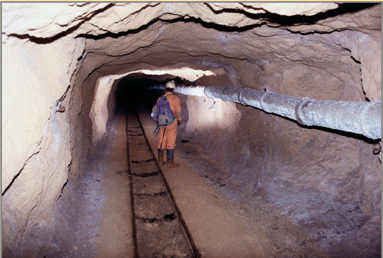
Galería de transporte en la mina Las Ligorias, en la zona oriental del yacimiento, de sección aprox. de 3 m x 2 m en roca viva. Foto: M. Hedrosa, 10/1998.
