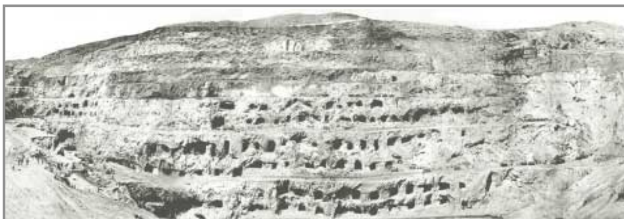
Vista del talud Norte de la Corta de Filón Sur (Riotinto) a finales del siglo XIX. Obsérvense las numerosas labores de interior descubiertas y la no correspondencia de las cámaras y los pilares en los pisos altos, causa de varios hundimientos a lo largo de los siglos XVIII y XIX. Foto cedida por F. Salgado.
