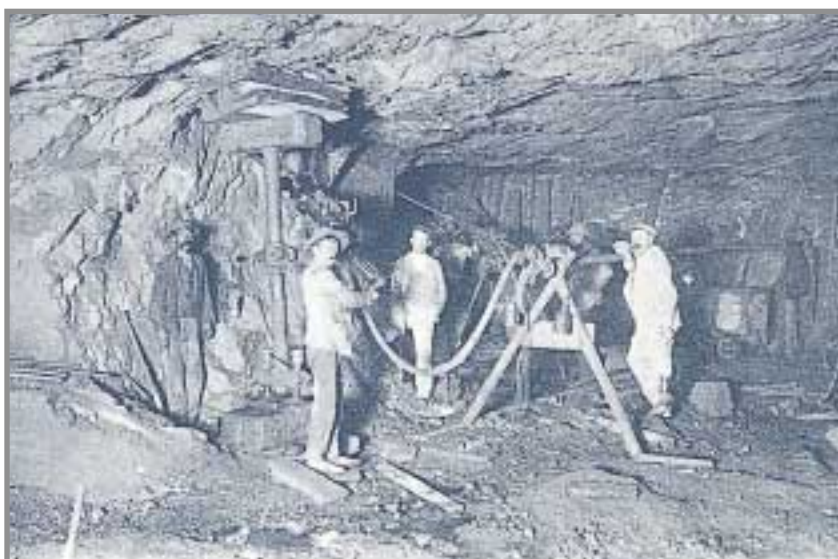
Mina El Perrunal. Mineros abriendo barrenos con perforadora en contramina. Foto hecha por la Cia. de Río Tinto a finales del siglo XIX. Cortesía de Pedro Real.
