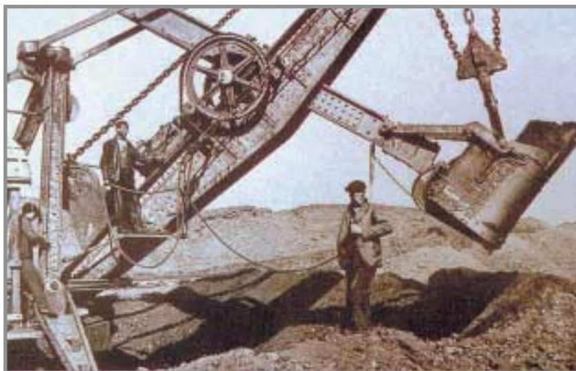
Detalle de la pluma y el cazo de una excavadora a vapor Bucyrus en Corta Dehesa (hacia 1900). La misión del hombre sobre la plataforma es tirar de la cadena que acciona el pestillo y que permite la apertura del cazo para vaciarla. Foto cedida por F. Salgado.
