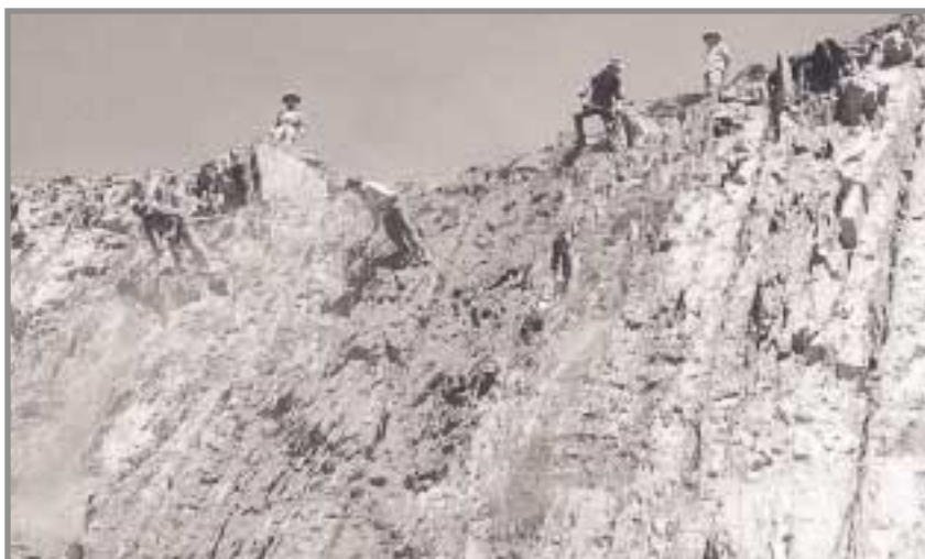
Mineros descolgándose por un talud de la Corta Atalaya para hacer labores de saneo y evitar posibles desprendimientos sobre el banco inferior (1963). Foto: M. Díaz Vega. Cortesía de Pedro Real.
