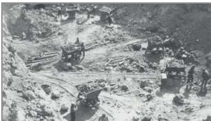
Zafreo a mano y transporte con vagones de doble vuelco en las proximidades de un pozo de vacie en Corta Atalaya (h. 1930). Foto cedida por Fundación Riotinto.
