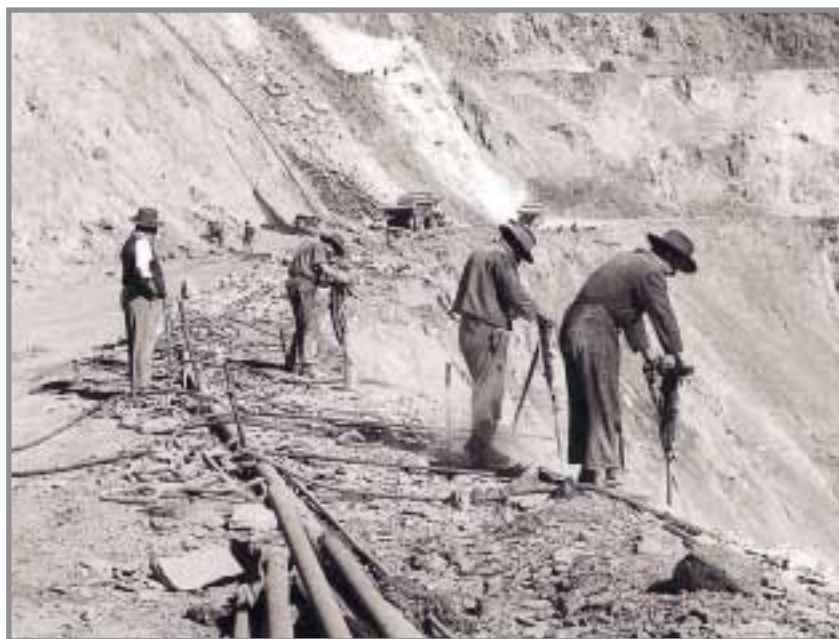
Mineros perforando barrenos en Corta Atalaya (Riotinto), en el año 1963. Tras ellos se pueden ver las picas y cuerdas que utilizaban los trabajadores para descolgarse por el talud y hacer labores de saneo después de las voladuras. Foto: M. Díaz Vega. Cortesía de Pedro Real.
