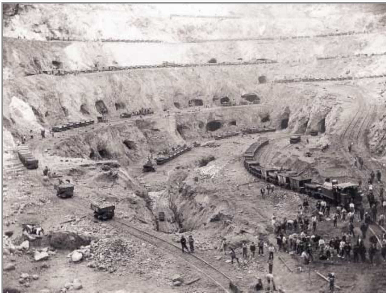
Panorámica de la Corta Filón Norte de Riotinto (finales del siglo XIX). Obsérvese como las labores a cielo abierto cortan las galerías y pilares de los antiguos trabajos subterráneos. Foto cedida por Pedro Real.
