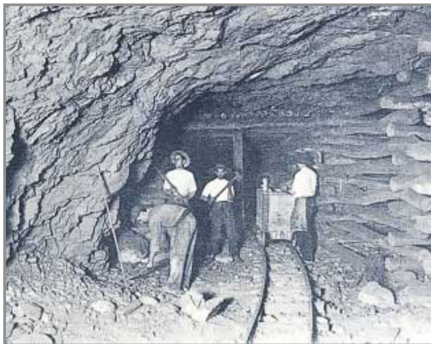
Mina El Perrunal. Mineros abriendo barrenos a mano en contramina. Foto realizada por la Cia. de Rio Tinto a finales del siglo XIX. Cortesía de Pedro Real.
