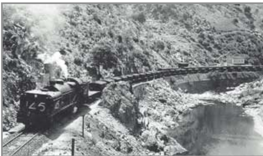
Locomotora Garrat tirando de un tren cargado de mineral hacia el puerto de Huelva. El tren está formado por 50 vagones tipo "M", con una capacidad de 30 t cada uno. A la derecha se puede ver el río Tinto (h. 1960). Foto cedida por F. Salgado.
