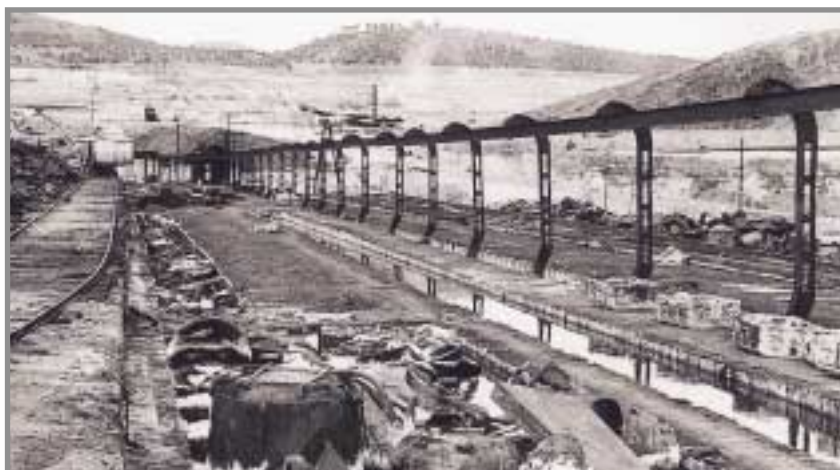
Canaleos en la Cementación de Naya (1963). Toda la chatarra de la empresa se llevaba a la planta de cementación para utilizarla en la precipitación de la cáscara de cobre. Este trabajo se realizaba a mano a principios de siglo. Más tarde se emplearon excavadoras sobre railes, como la que se ve en la fotografía (al fondo). Foto: M. Díaz Vega. Cortesía de Pedro Real.
