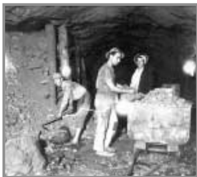
Pareja de zafreros cargando con rodo y espuela un contino de 1,5 t en una trinchera de la contramina San Dionisio - Alfredo (h. 1960). La tarea típica para cada pareja consistía en cargar 20 continos (30 t de mineral). Foto cedida por F. Salgado.
