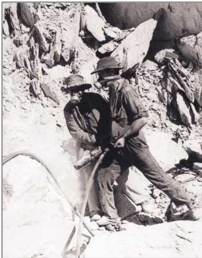
Mineros realizando trabajos de perforación en pórfido. Corta Atalaya (1963). Foto: M. Díaz Vega. Cortesía de Pedro Real.
