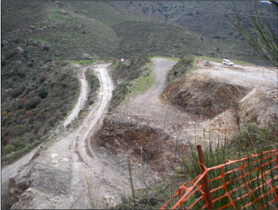
Figura 4: Detalle de los bancos de explotación durante trabajos de acondicionamiento de los niveles superiores (Fot. Carlos González Bargeño, 2009).
