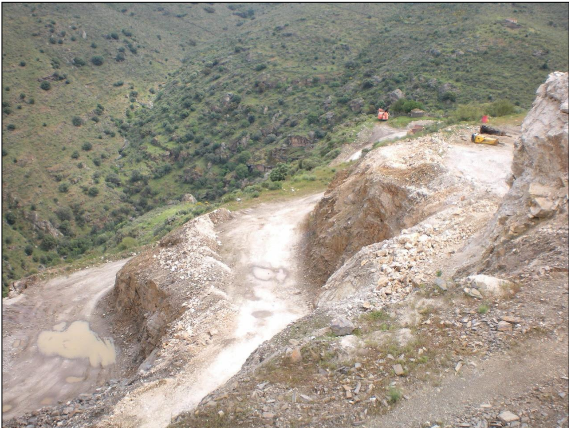
Figura 5: Otra vista de los niveles superiores donde se aprecian varios martillos hidráulicos (Fot. Carlos González Bargeño, 2009).
