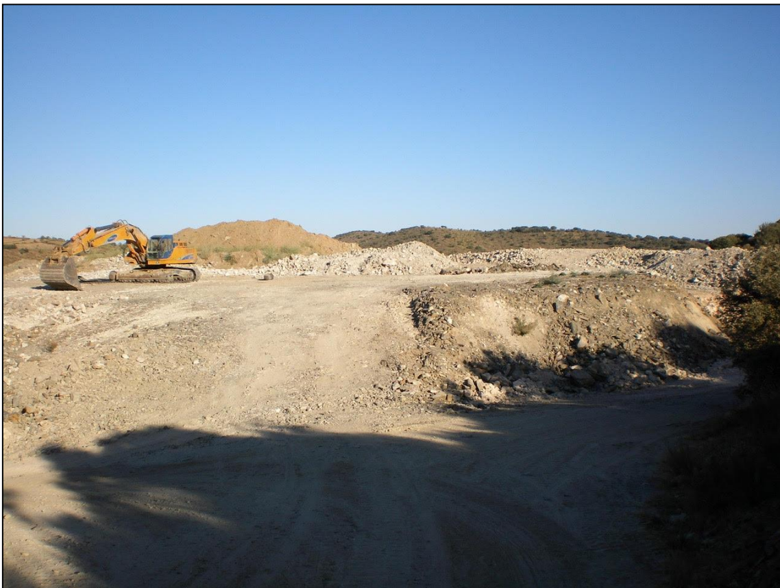
Figura 3: Maquinaria en la zona de escombrera dentro de la cantera Alberto I (Fot. Carlos González Bargueño, 2009).
