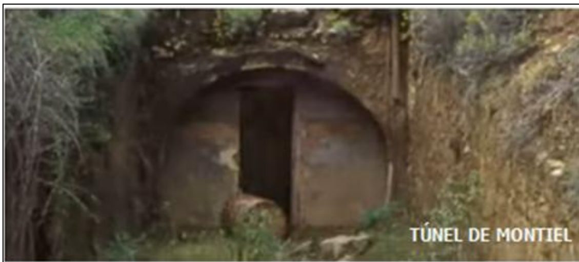
Figura 9: Embocadura del túnel de Montiel
