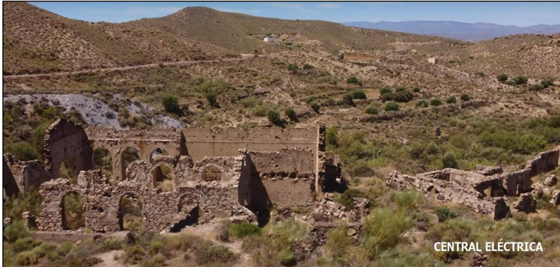
Figura 13: Restos de la Central Eléctrica (Fot. Gonzalo García, 2023)
