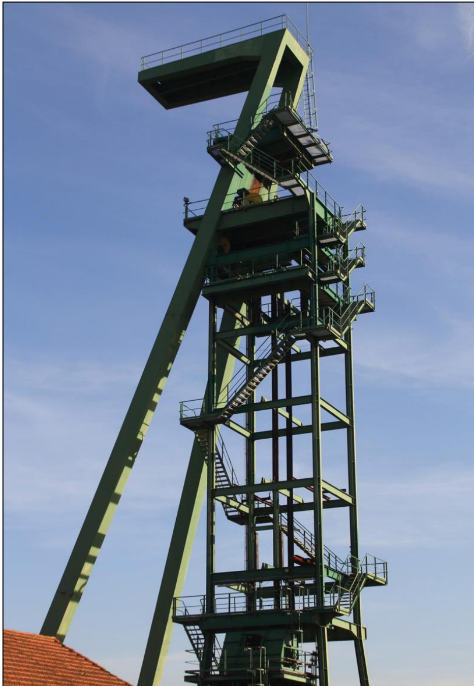
Figura 25: Castillete del pozo nº 2 de La Camocha, Gijón, Asturias (Fot.: J.M. Sanchis, 2002)
