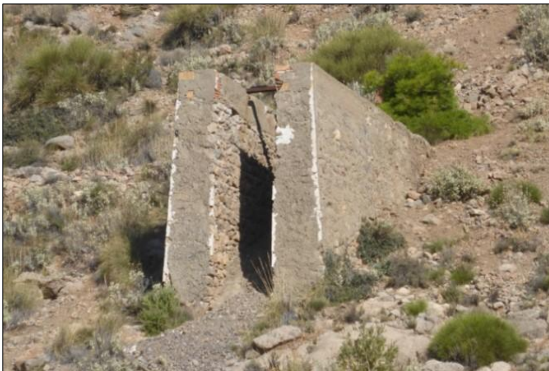
Figura 13: Estructura de carga del cable aéreo
