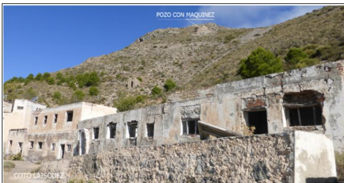
Figura 18: Edificaciones de exterior del Coto Láisquez a cota 1032 m s.n.m.
