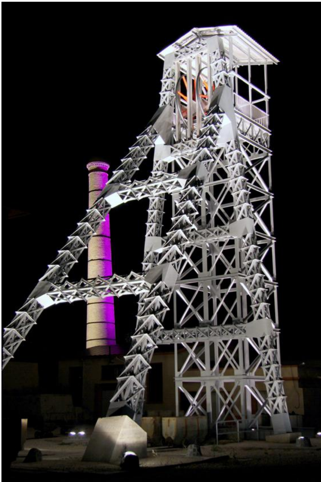
Figura 13: Castillete del pozo Santa Bárbara, Utrillas (Fot.: J.M. Sanchis, 2010)
