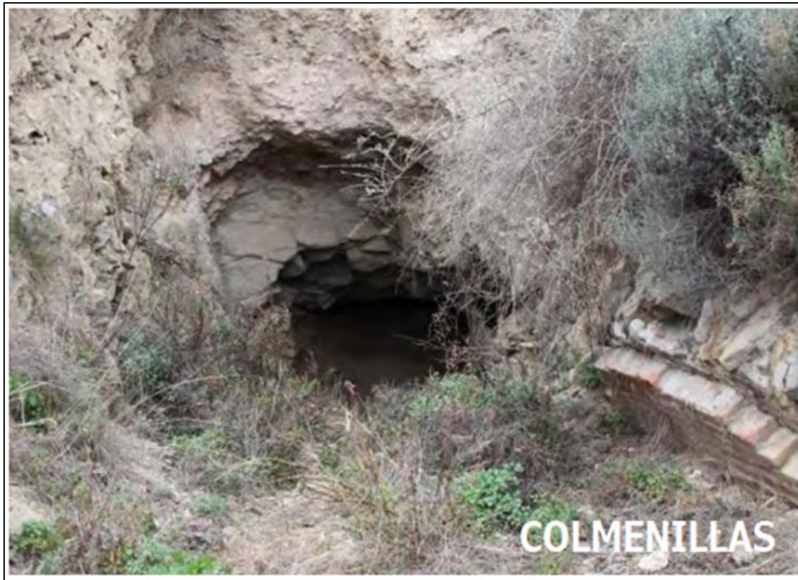
Figura 6: Estado actual de la embocadura del Socavón Colmenillas (Fot. Jesús Martínez Martínez, 2012)
