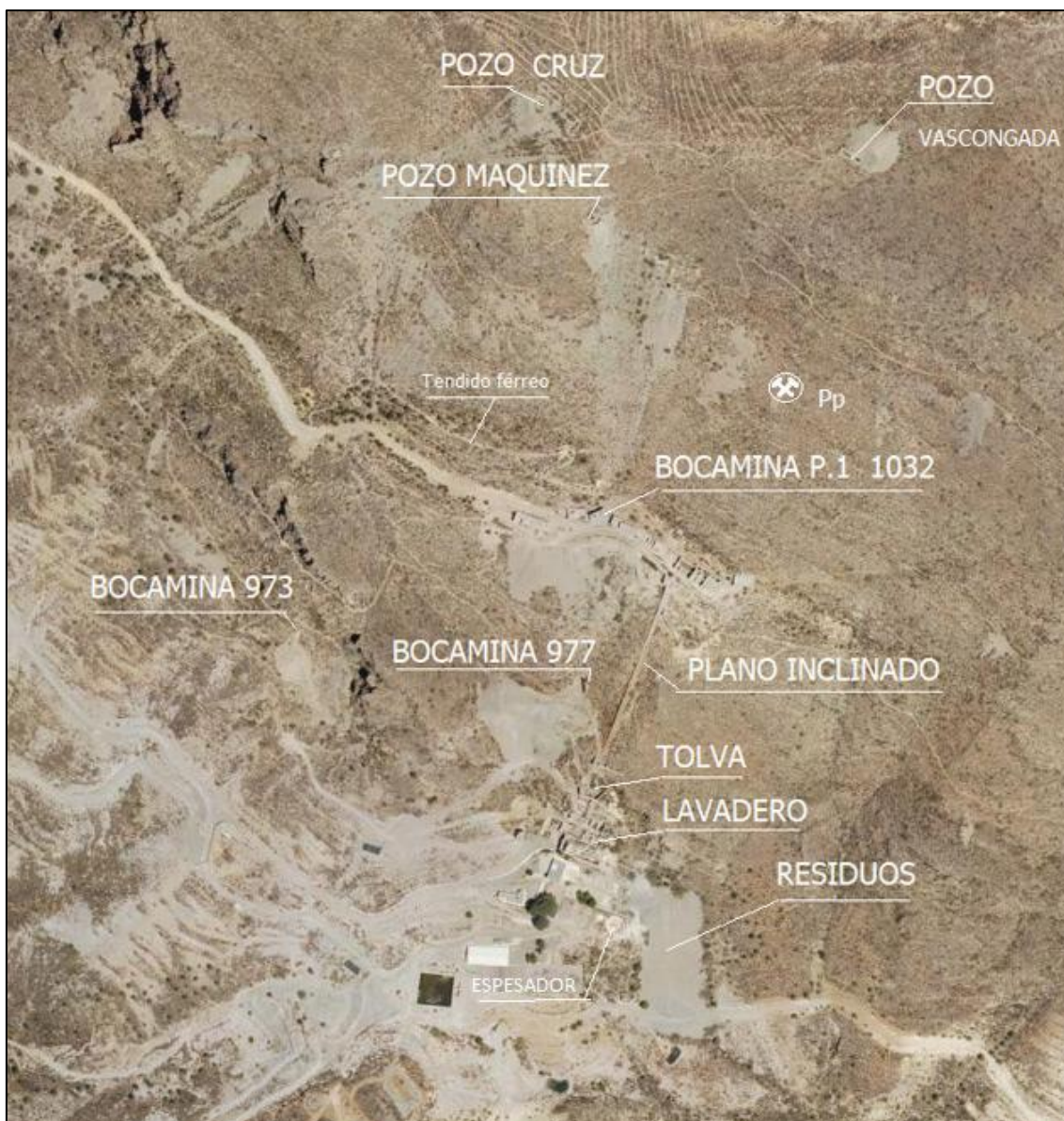
Figura 5: Fotografía aérea del Coto Láisquez. Instalaciones exteriores
