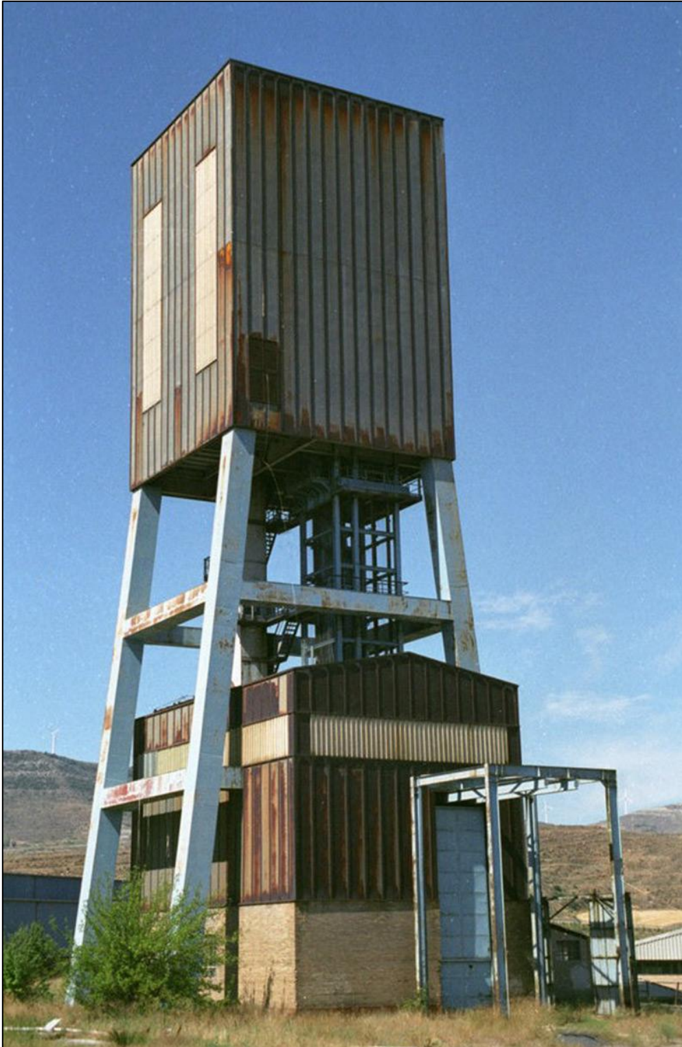
Figura 24: Pozo Pilar , Escucha, Teruel (Fot.: J.M. Sanchis, 2008)
