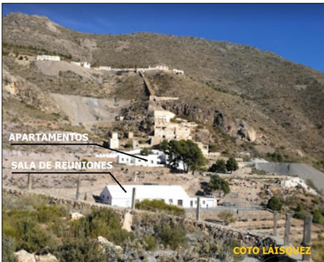
Figura 20: Aspecto actual del exterior del Coto Láisquez
